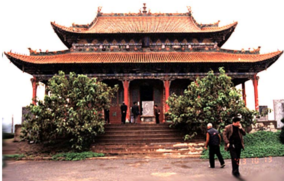
傳說祠大殿第一期工程主体
